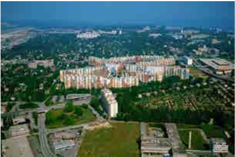
Abbildung 9: Göhner-Siedlung Avanchet Parc in Vernier, Genève (1971-77 gebaut), September 1985
