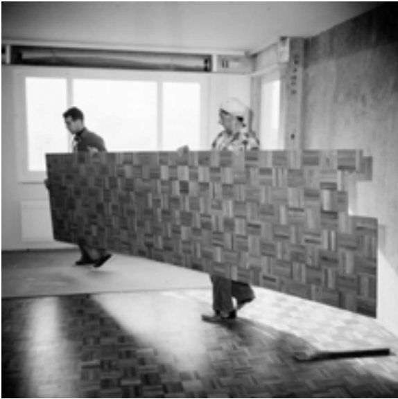
Abbildung 8: System Göhner, vorgefertigter Bodenbelag, September 1966
