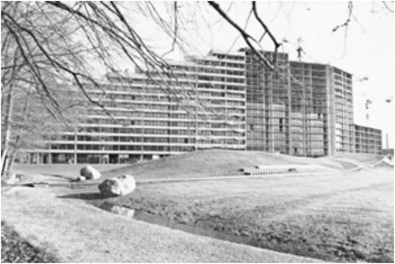
Abbildung 75: Wohnzeile A im Bau, 1972
