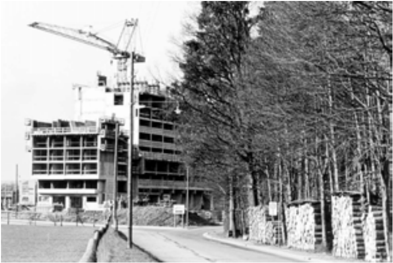
Abbildung 28: Unteraffoltern II im Bau, 1968
