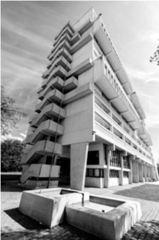
Abbildungen 36 und 37: Hauseingang auf Stützen
