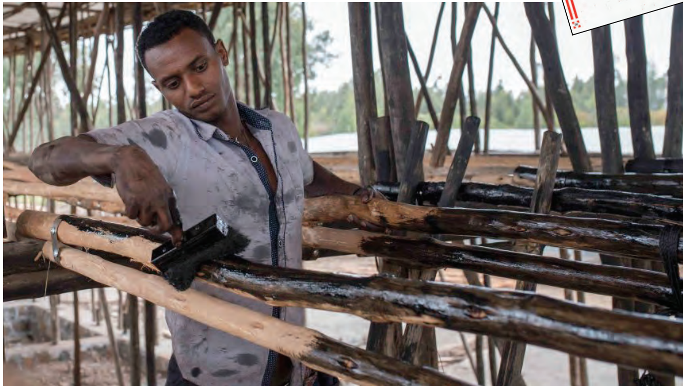
Arbeiter auf einer Baustelle in der Modellstadt Buranest in Äthiopien
